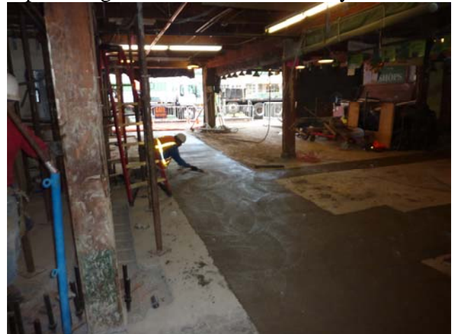
Corner Market Common Trench Pour Back
